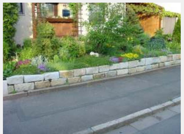
Mauersteine aus Granit
